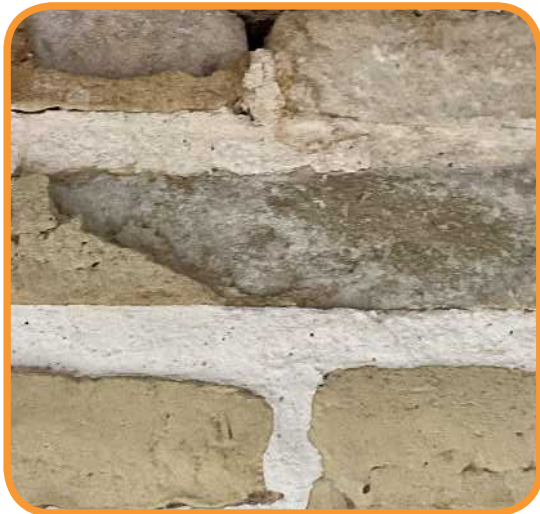
ظهور و بروز نمک های محلول در آجر (شوره) بر روی سطوح آجری بنا
