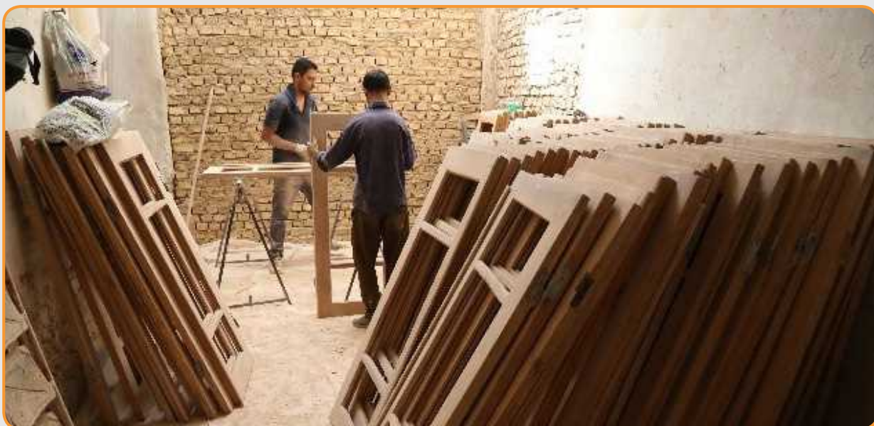
ساخت و نصب درب و پنجره های جدید جایگزین درب های فرسوده قبلی بنا
