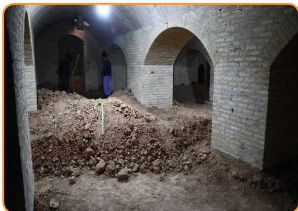
آواربرداری، جمع آوری نخاله و ضایعات و تخریب بخش های الحاقی موجود
