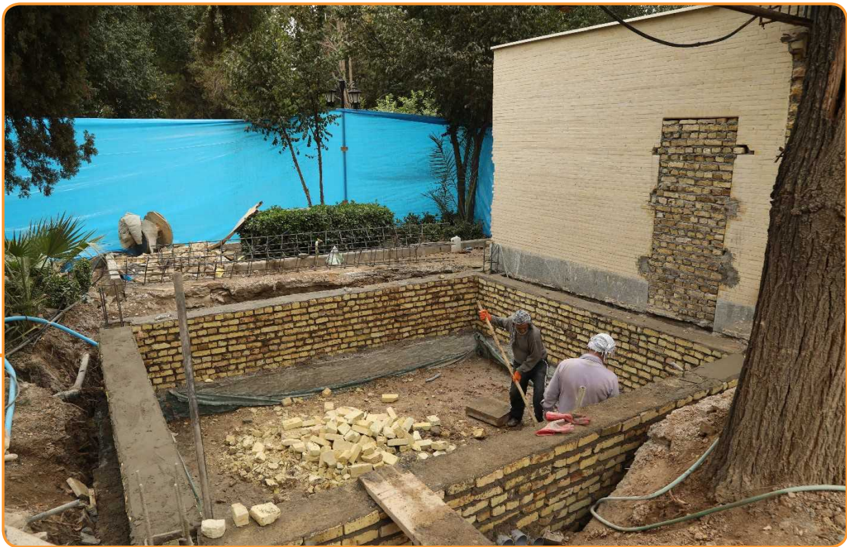
آماده سازی فضاهای جانبی شامل موتورخانه، فضای خدماتی و اتاق تاسیسات و...
