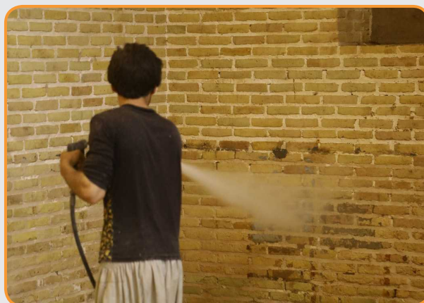
شستشوی نمای آجری و رفع زنگار از بدنه و بهبود منظری وضعیت بنا
