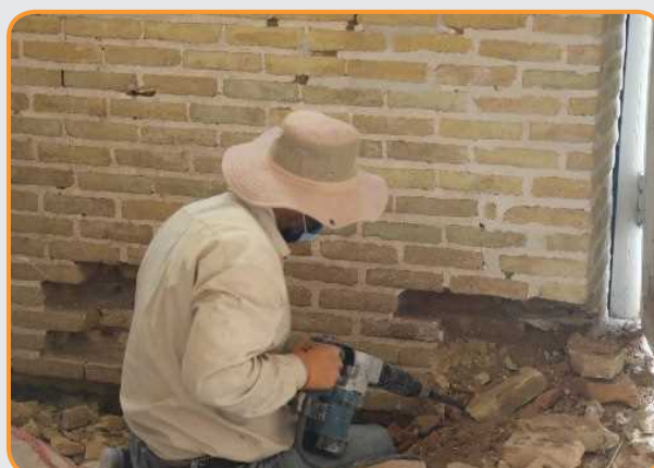
خارج کردن مصالح فرسوده، درب و پنجره های آسیب دیده و اندود های آسیب زای بنا
