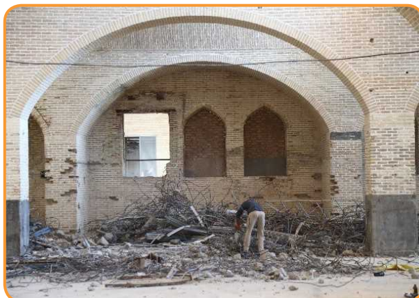
آواربرداری، جمع آوری نخاله و ضایعات و تخریب بخش های الحاقی موجود
